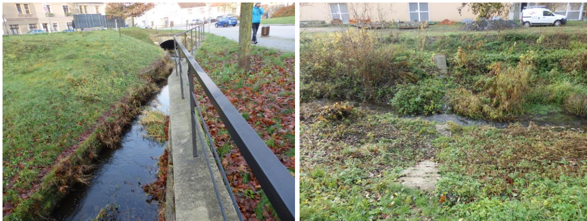
Obr. Zejména spodní část úseku je stabilizována zídkami, ve dně jsou osazeny stabilizační prahy.
